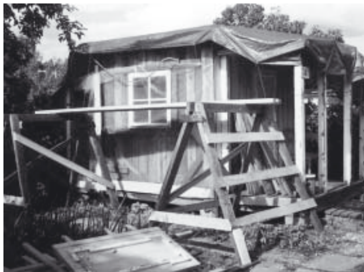
Museomökin remontti tehtiin kesällä 1996, jolloin 1920-luvun alkuperäinen asu tuotiin takaisin.
